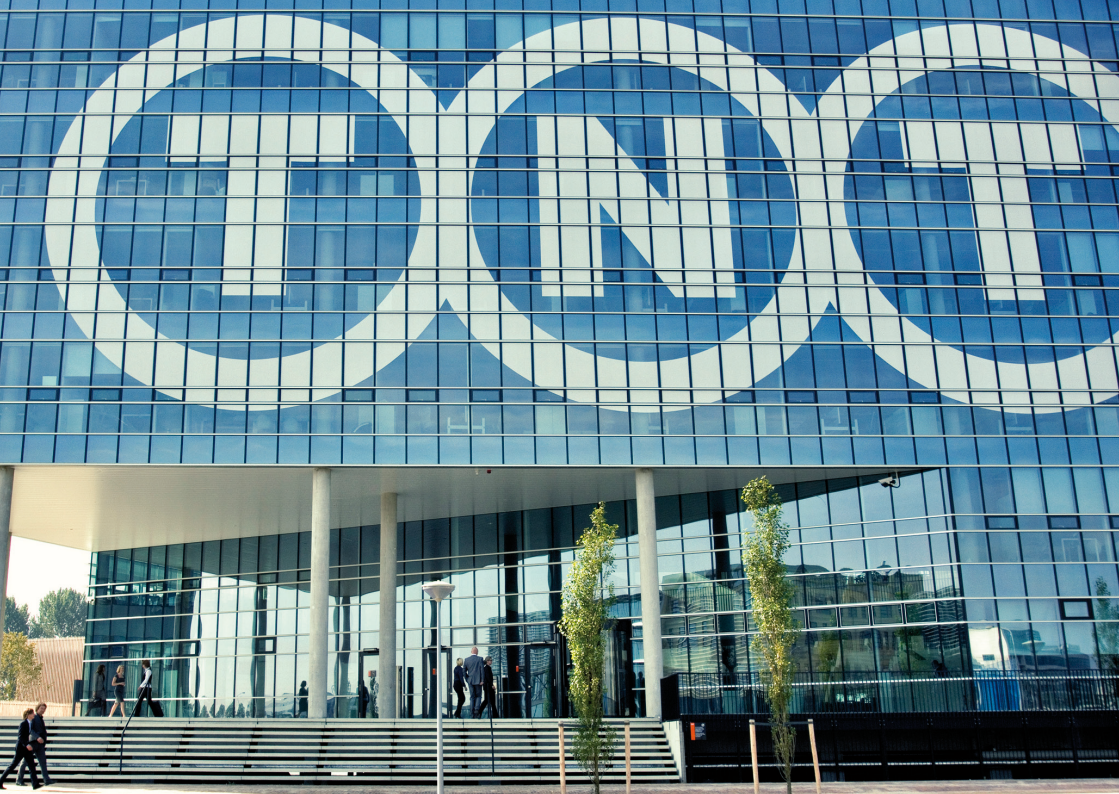
Sustainable TNT Centre - Hoofddorp, Entree, foto: Bowie Verschuuren
