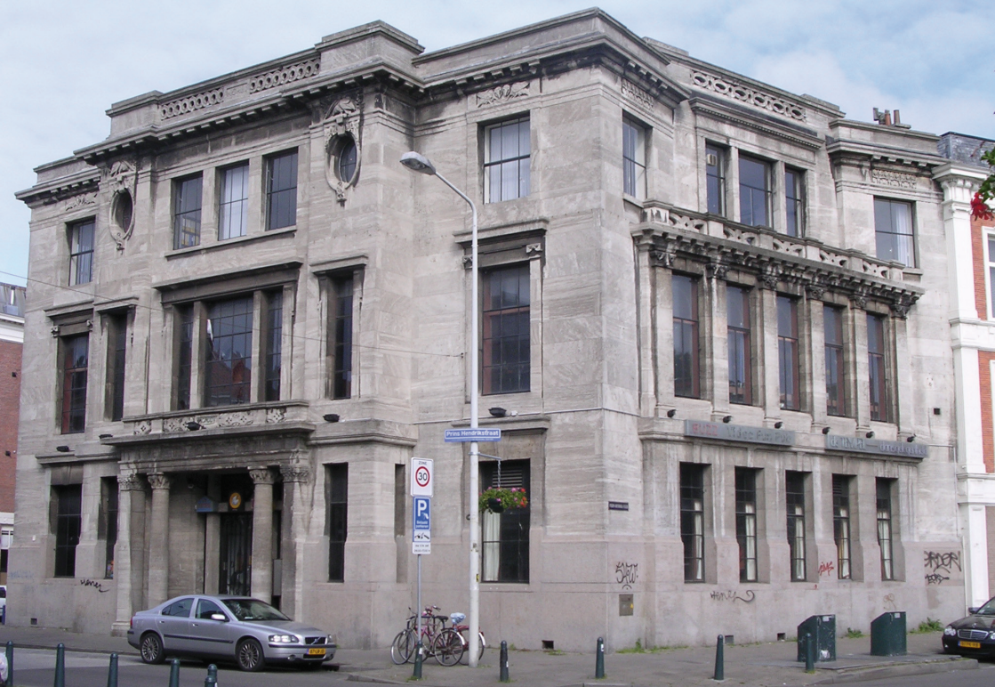
Kantoor en archief De Tempel - Den Haag, overzicht gevel
